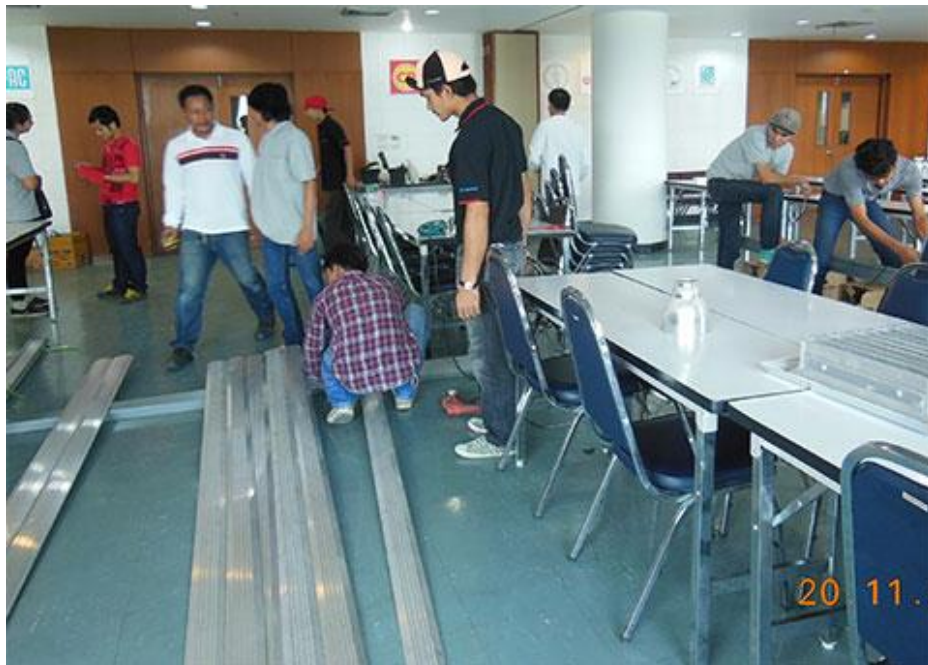
Ntamp Co., Ltd. นำโดยคุณวิรัช ภาคไฟฟ้า และภาคคอมพิวเตอร์ วสท. ระดมช่างผู้ชำนาญ เข้าดำเนินการจัดเตรียมวัสดุ และติดตั้ง BackBone Gigabit Switch 48ports สำหรับระบบ LAN พร้อม Wall Mount Rack 9U แบบมีพัดลมดูดความร้อน และ AC power 6Outlets ในระหว่างวันที่ 15 ถึง 21 พฤศจิกายน 2556 ซึ่งแล้วเสร็จตามกำหนด
